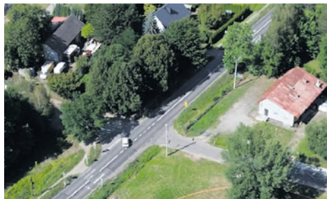
Remont skrzyżowania w Jajostach.
