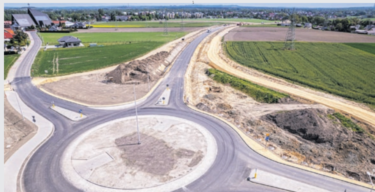
Przy ulicy Kościelnej powstało rondo. Teraz budowany jest łącznik tego ronda z nowo powstającym rondem na ulicy Jagiełły.
