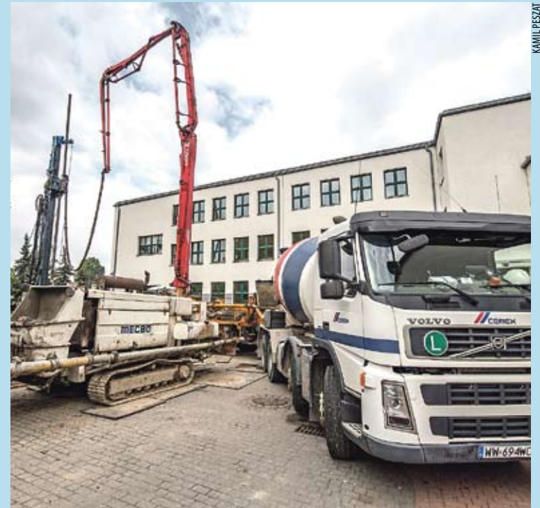
Rozpoczęło się „palowanie” czyli wzmacnianie gruntu pod fundamenty.
