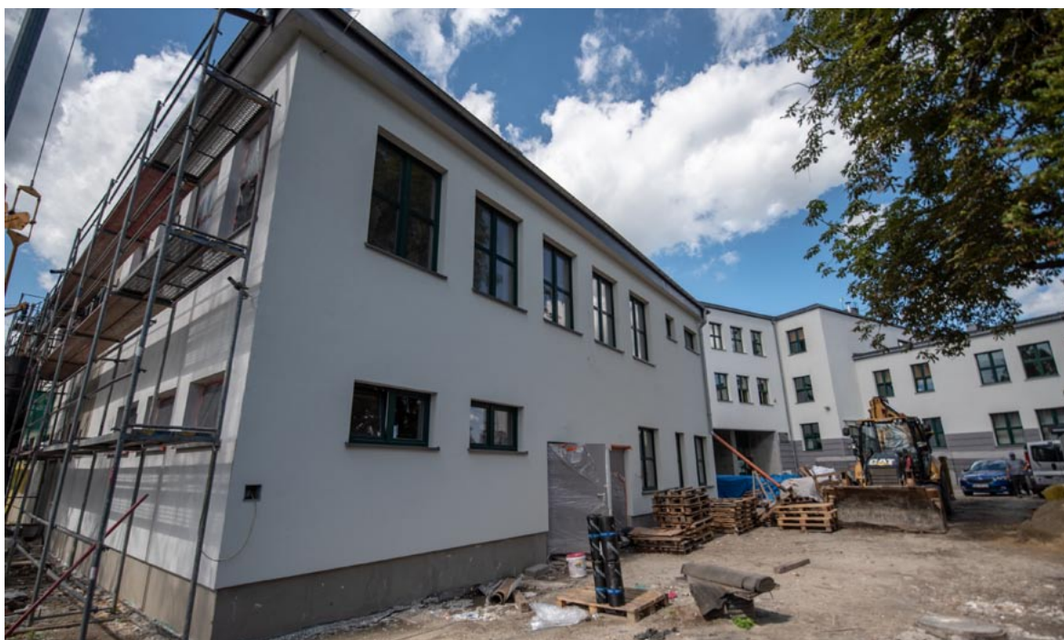
Elewacja nowego skrzydła jest prawie gotowa i tworzy spójną całość z głównym budynkiem szkoły, który w 2019 r. przeszedł termomodernizację.
