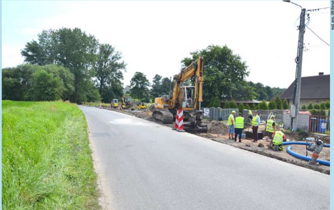
Prace przy ul. Wita ruszyły pełną parą.
