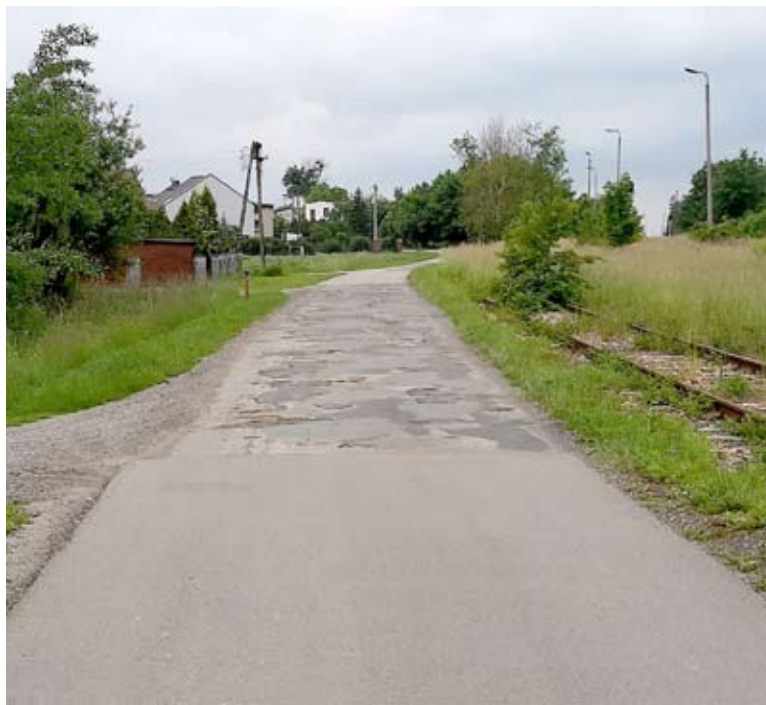
Odcinki wyremontowanej przez kopalnię drogi przetykane są zniszczonymi fragmentami, o naprawę których miasta stara się od lat.
