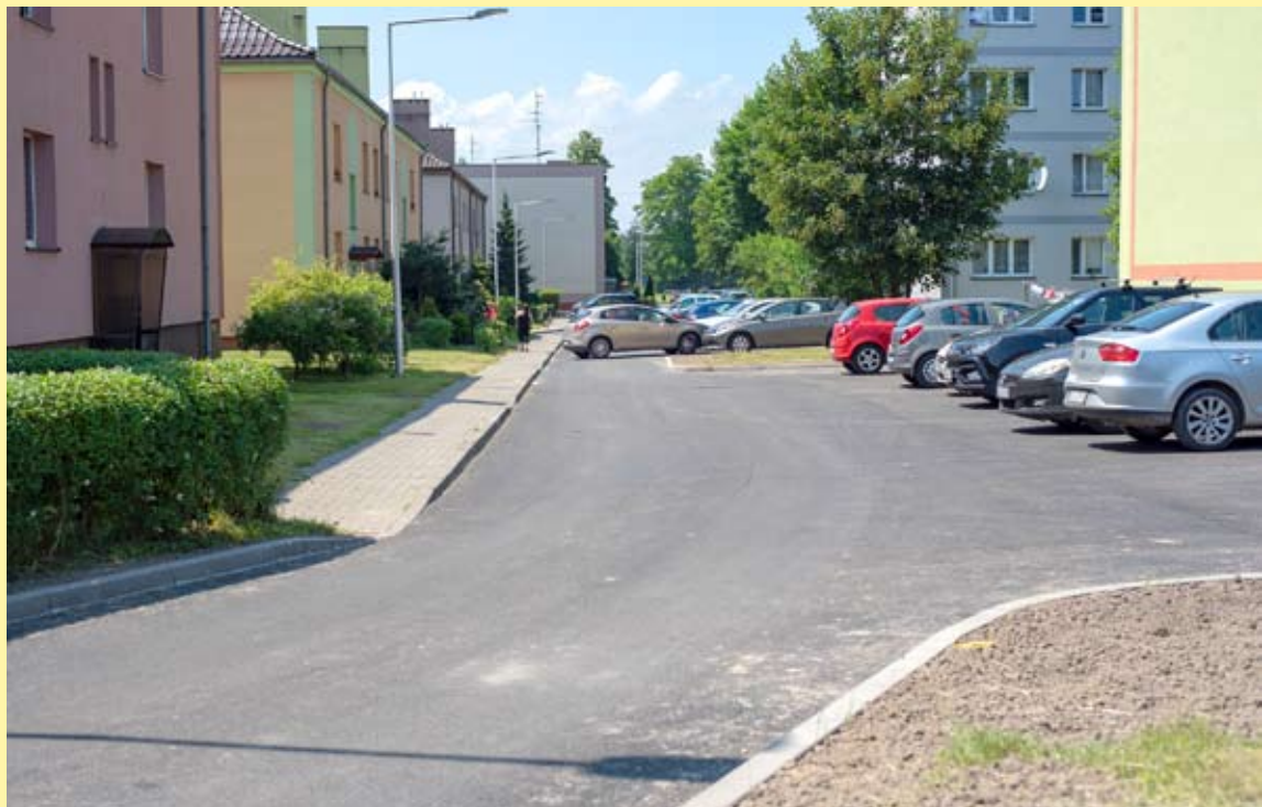
Droga wewnętrzna z nowym asfaltem czeka na odbiór techniczny.
