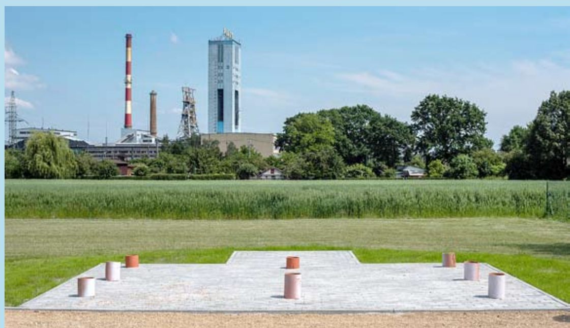
Miejsce pod wiatę zostało już wyłożone betonową kostką.
