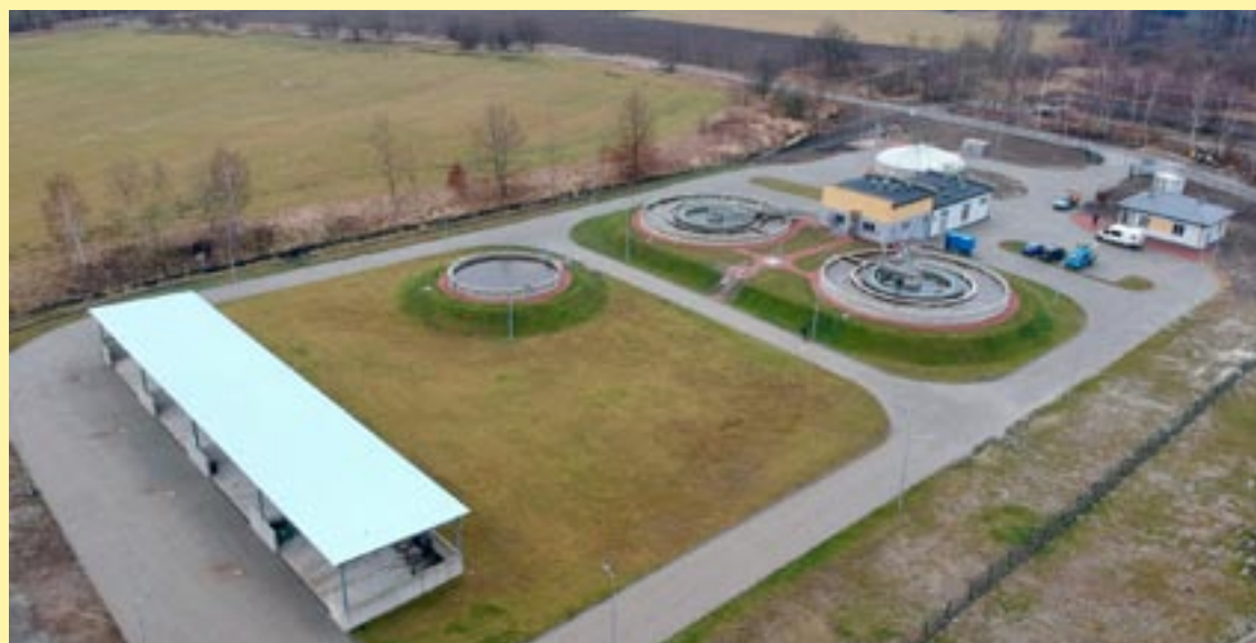
Po modernizacji poprawiły się parametry techniczne obiektu, a przy tym zajmuje on teraz mniejszą powierzchnię.
