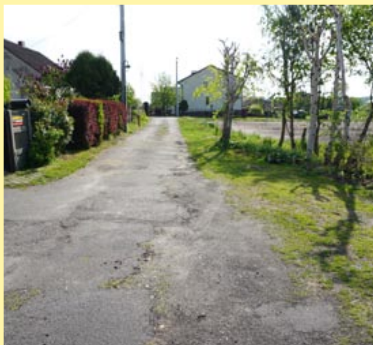
Ulica Bijasowicka boczna przed remontem. Niedługo jej stan bardzo się poprawi.
