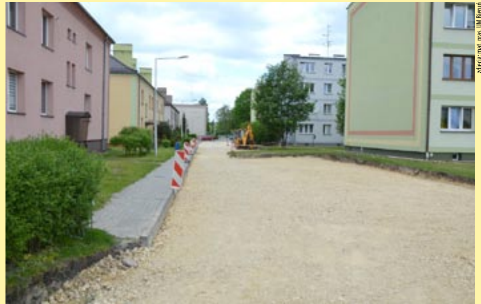
Trwają też prace przy budowie osiedlowej drogi wewnętrznej.
