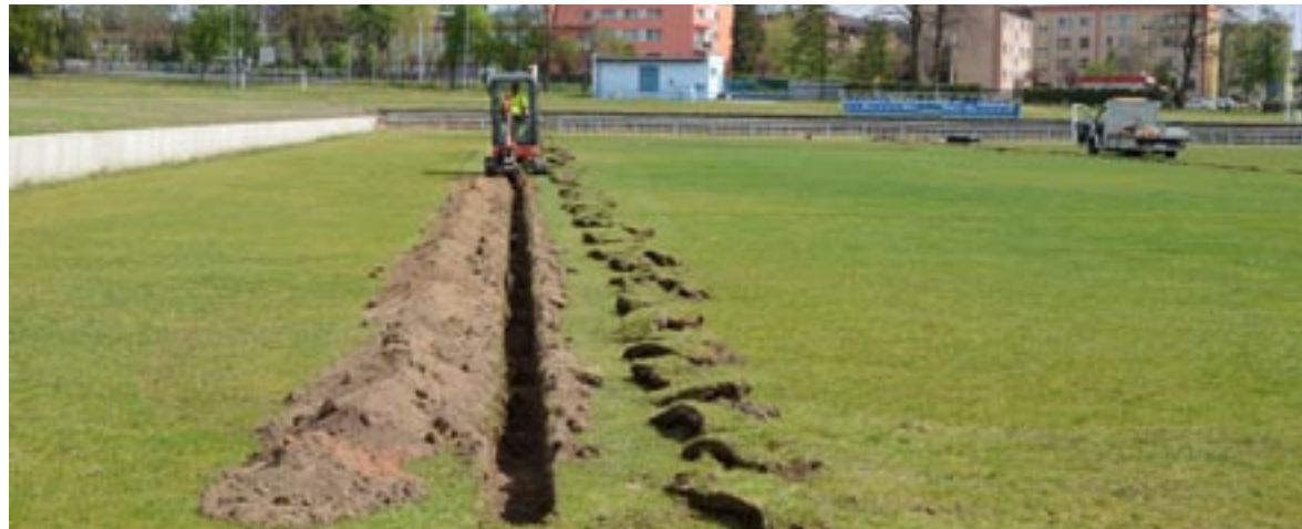
Przy ul. Chemików powstanie Orlik. Na razie zamontowano zraszacze nawadniające płytę boiska.
