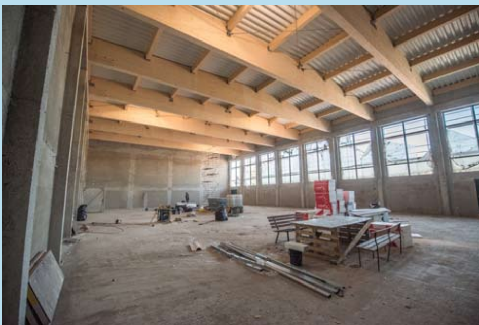
Wewnątrz sali gimnastycznej trwają roboty instalacyjne.
