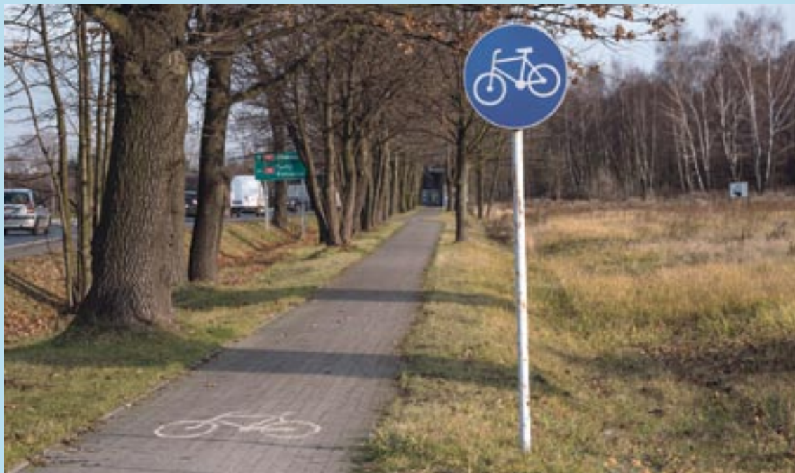
Droga rowerowa pomiędzy Bieruniem Starym a Bieruniem Nowym także zostanie oświetlona. Prace już ruszyły.
