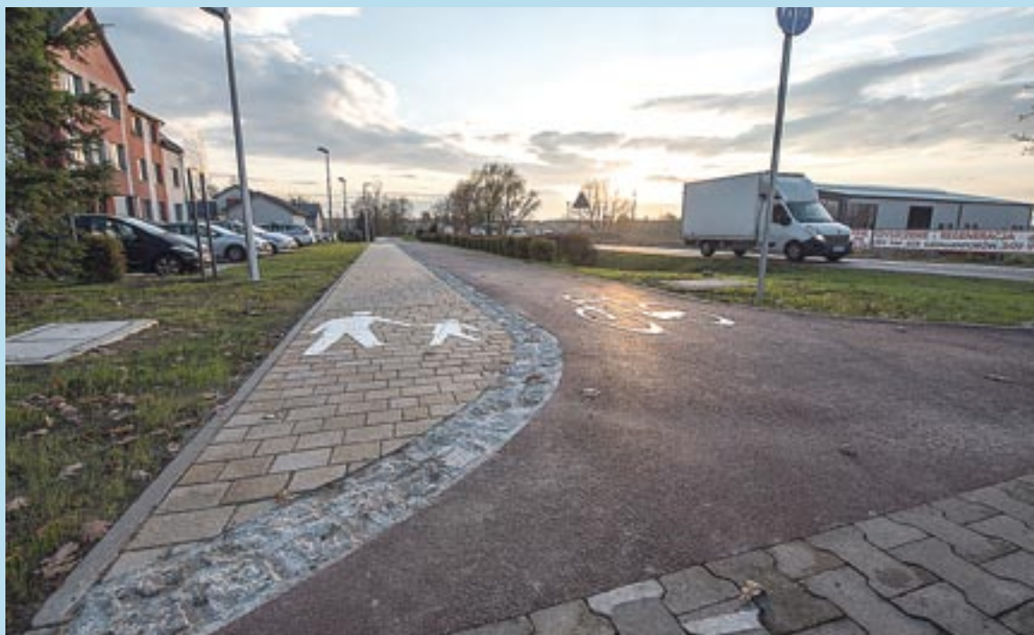
Kolejny odcinek drogi rowerowej ułatwił poruszanie się jednośladem po mieście. W przyszłym roku droga będzie przedłużona aż do Zarzyny.
