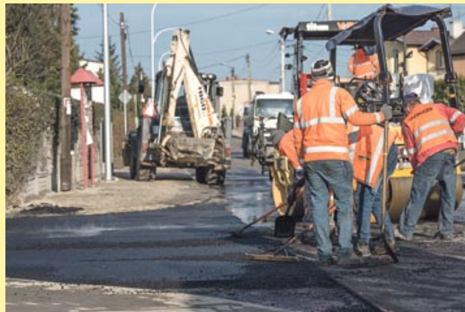
Pod koniec listopada układano asfalt na ostatnim odcinku ul. Marcina.
