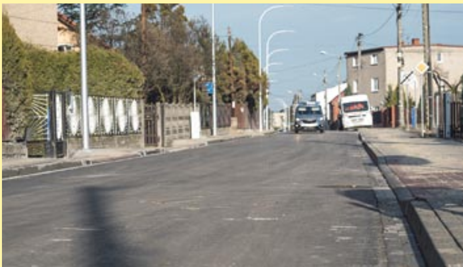
Po jednej stronie wyremontowanej ulicy, na części wyłożonej betonową kostką zamontowano słupy oświetleniowe. Ułatwi to w przyszłości dostęp do zlokalizowanych tam bezpieczników, w przypadku ewentualnej awarii. Pełnowymiarowy chodnik, po którym można się wygodnie poruszać, wybudowano po drugiej stronie ulicy.
