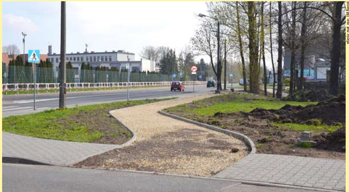
Na ul. Chemiczków widać już postęp prac przy budowie ścieżki rowerowej i chodnika.
