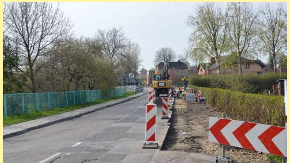
Intensywne prace na ul. Kopcowej mogą powodować utrudnienia.
