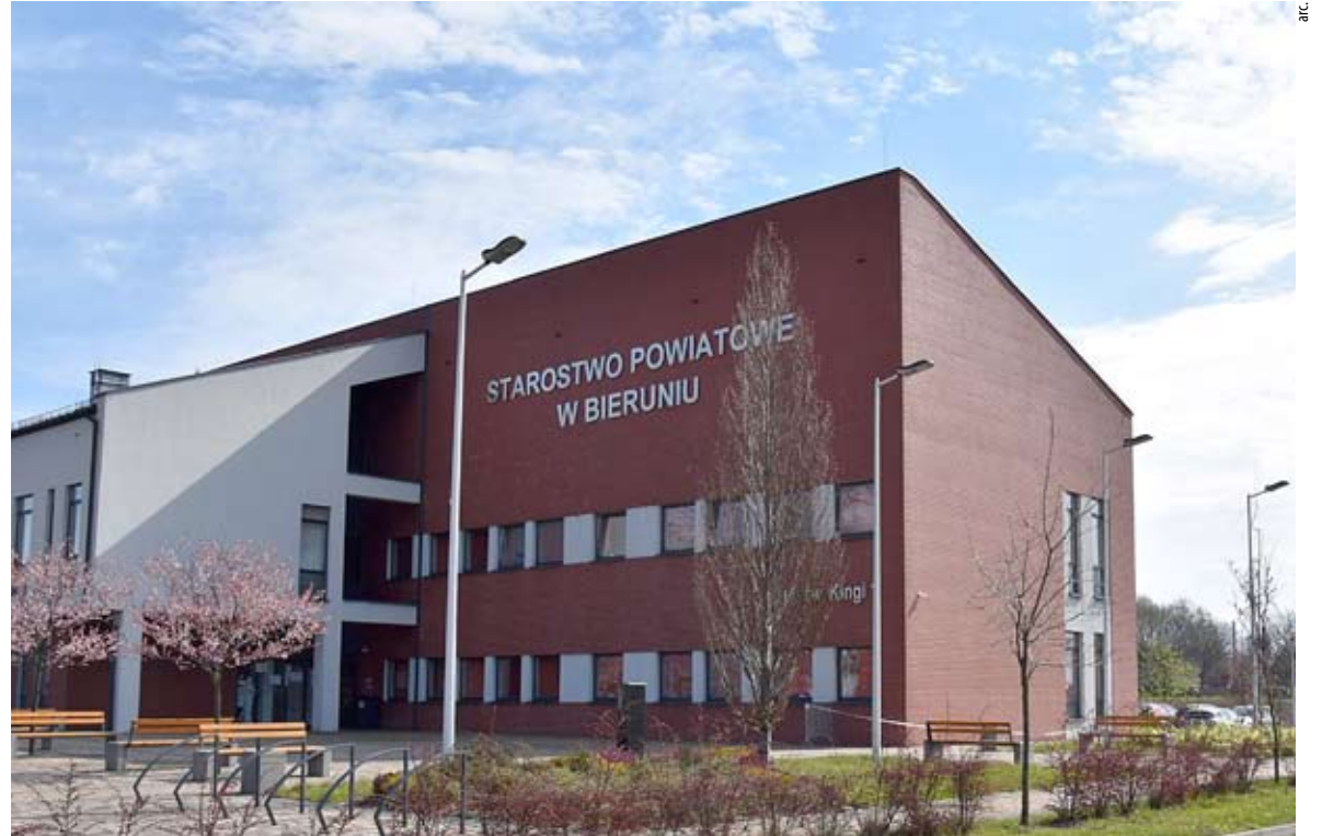
Budynek starostwa będzie jednym z tych w dzielnicy Ściernie, które zostaną podłączone do kanalizacji.
