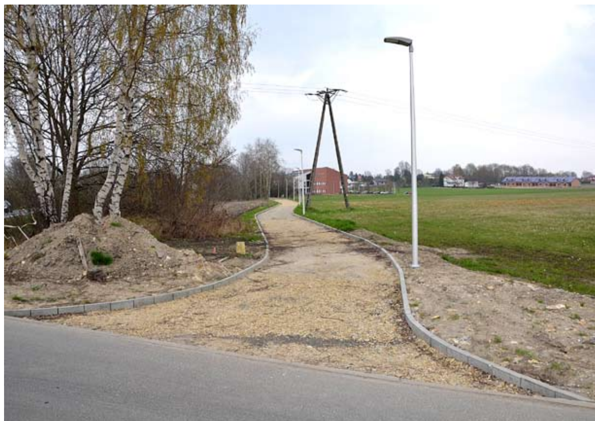
Przy prawie skończonych już drogach stanęły słupy oświetleniowe z oprawami LED.
