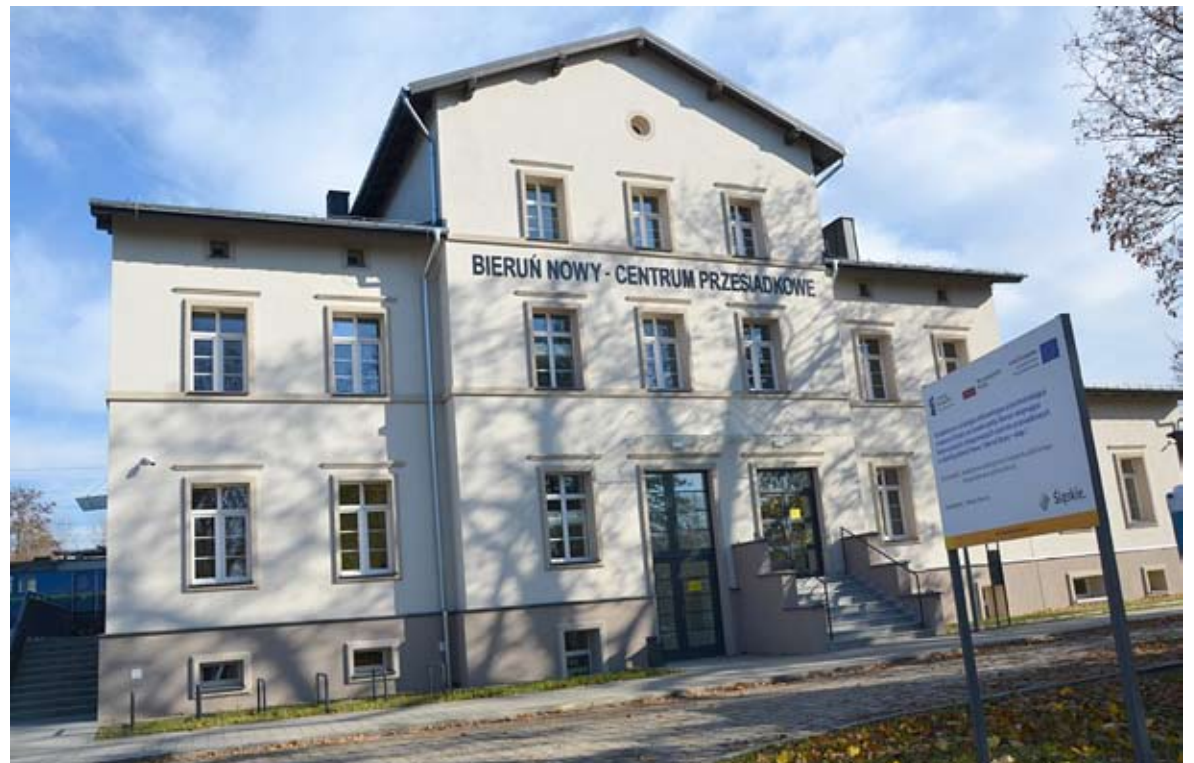
Przebudowa dworca PKP na Centrum Przesiadkowe.
