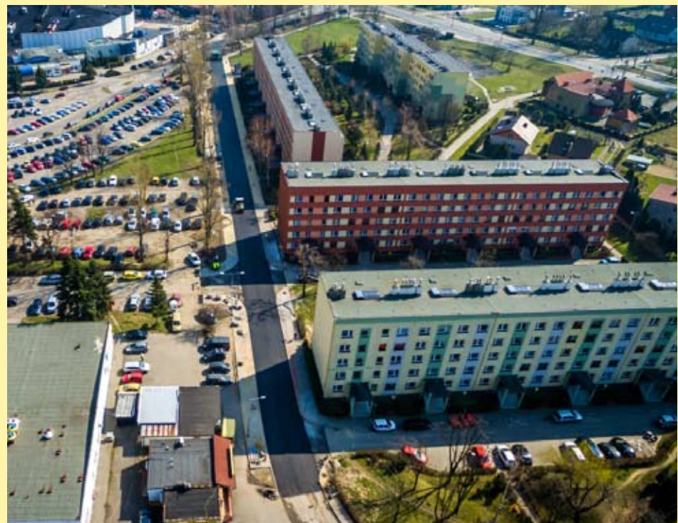
Na Granitowej trwa już asfaltowanie.
