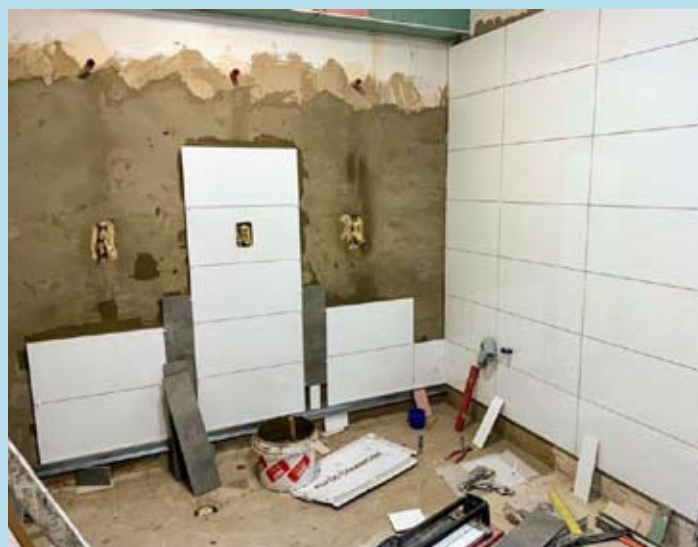
Zaplecze sanitarne w hali sportowej Gimnazjum nr 2 właśnie przechodzi remont.
