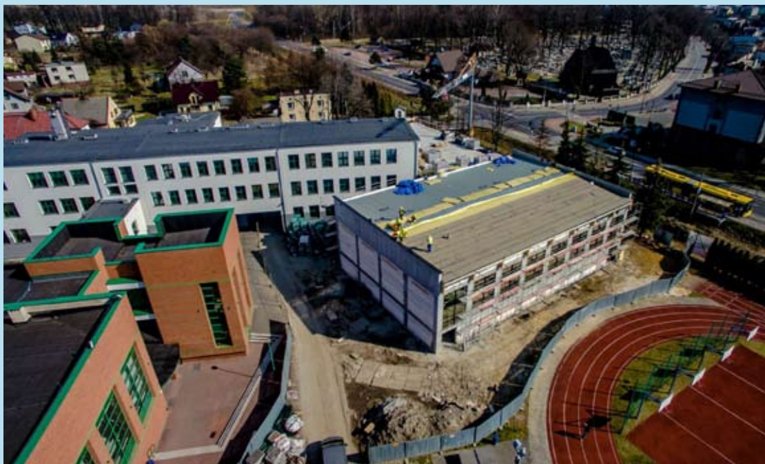
Trwają prace przy pokryciu dachu nowego skrzydła szkoły.
