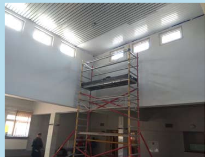
W „Remizie” trwa malowanie sufitu w głównej sali. / BOK
