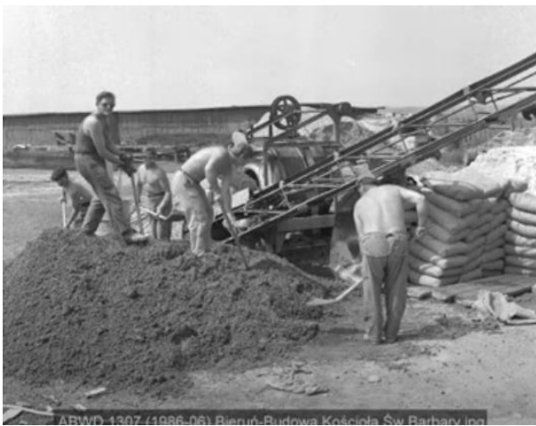
2. Budowa probostwa i salek katechetycznych, 1986 r. Szczepan Ścisłowicz, Platforma YouTube
