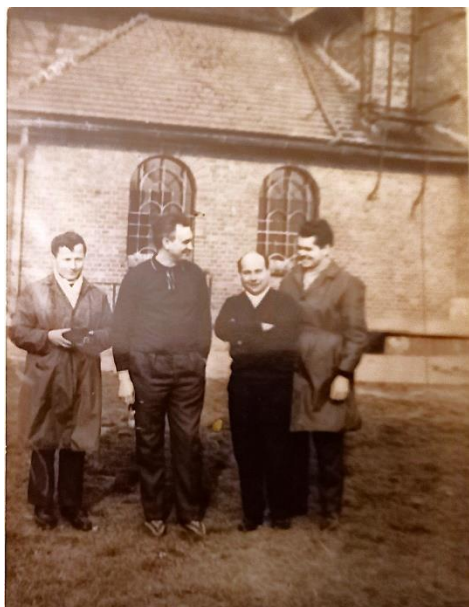
7. Ks. prob. B. Kuczera i wikary ks. J. Kupka z wykonawcami instalacji grzewczej, 1971 r. Widoczny komin kotłowni węglowej. Z archiwum parafii NSPJ
