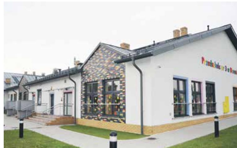
■ W 2016 roku zakończono budowę nowego przedszkola
