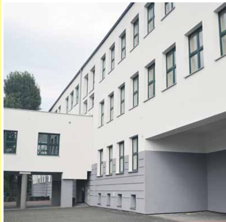
■ Termomodernizacja budynku Szkoły Podstawowej nr 1
