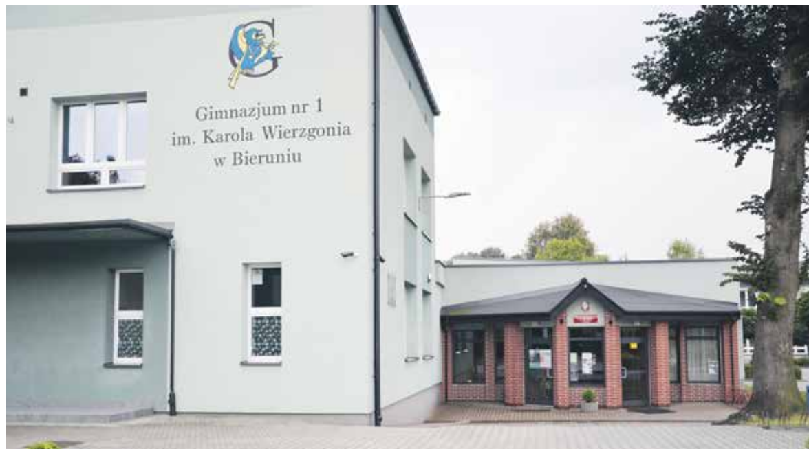
■ Generalny remont Gimnazjum nr 1
