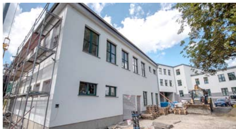
Budowane od 2019 roku skrzydło SP1 z nową salą gimnastyczną będzie gotowe już na wiosnę tego roku.
